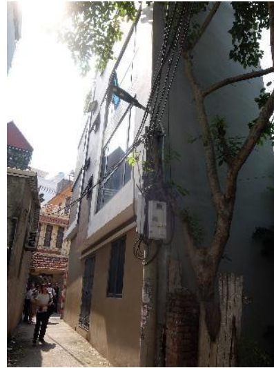
Nhà 4 tầng hoàn thiện năm 2019 tại thành phố Hà Nội
