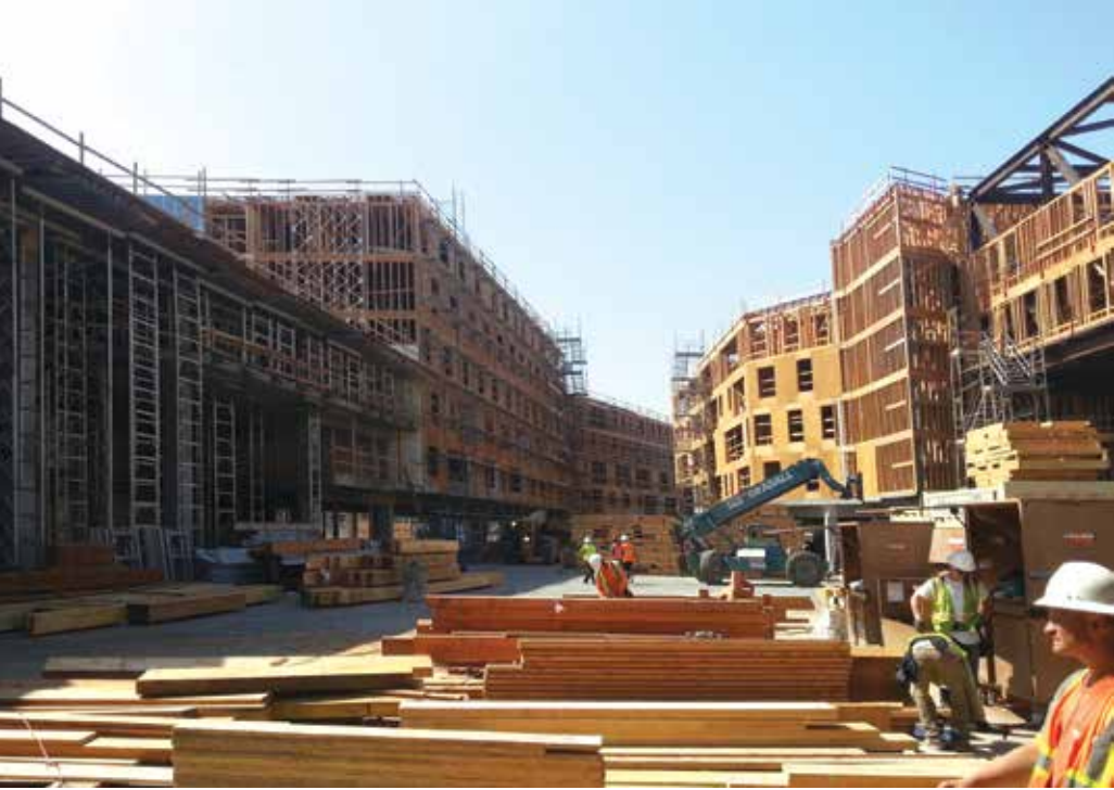
MỘT CÔNG TRÌNH ĐANG THI CÔNG TẠI MỸ
